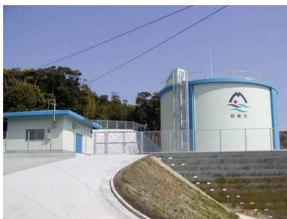
木場配水池：V=3,000m 3 （耐震構造）
