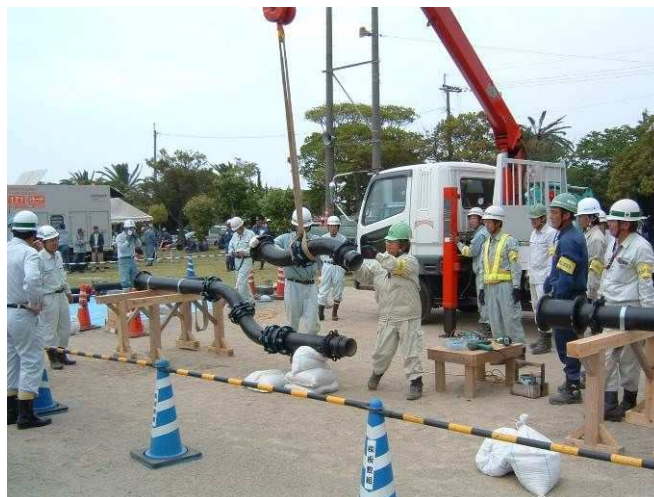
応急復旧訓練状況
