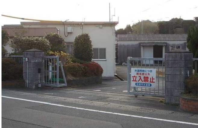
深浦ポンプ場
