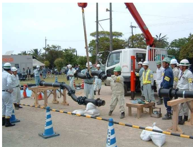
応急復旧訓練状況
