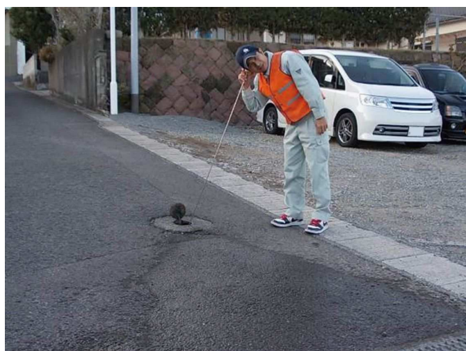
効率的な漏水調査の実施
