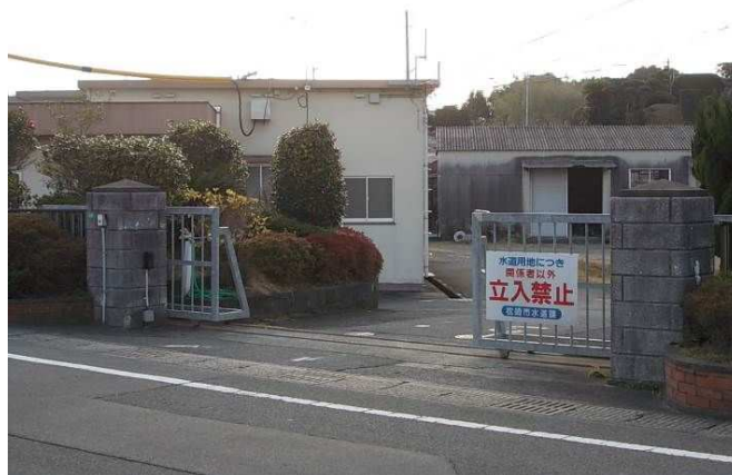
深浦ポンプ場
