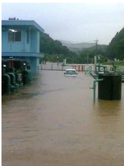
金山浄水場の冠水状況 (平成5年度)
