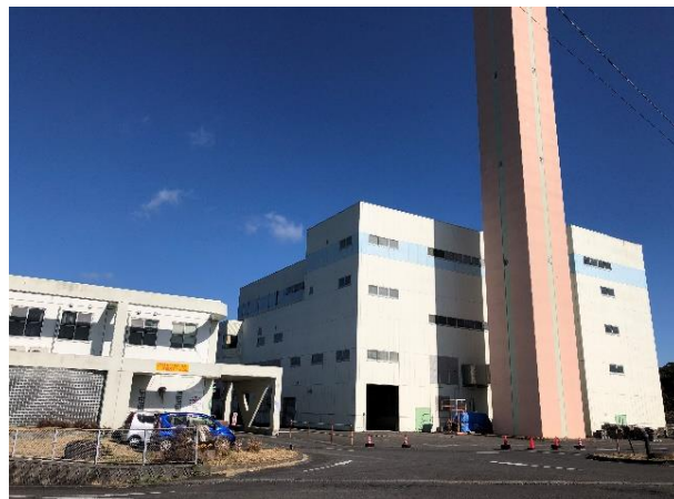
【南薩地区衛生管理組合内鍋清掃センター】
