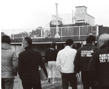
下水道終末処理場の現地確認
