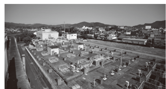
下水道処理施設
