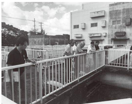
下水道終末処理場の最終沈澱池
