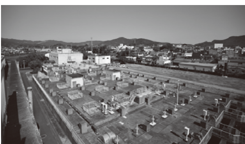
下水道処理施設
