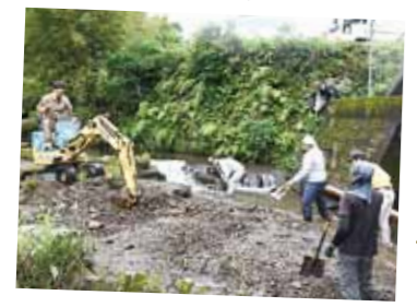
水源地等の 清掃作業を実施
