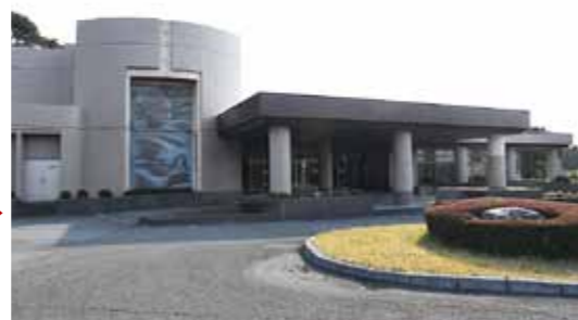
▲建設から18年経過した枕崎共同斎場の火葬炉の入替えや施設・駐車場の整備を行います。
