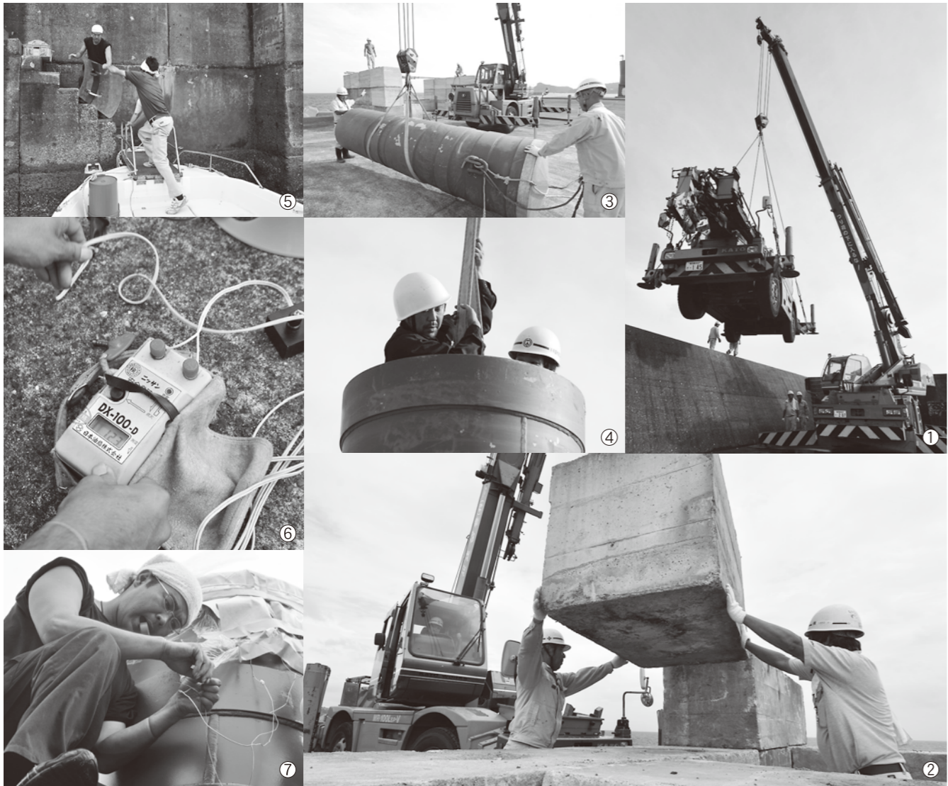
①堤防の段差を越えるためクレーンで重機や資材を吊り上げていく。②基礎となるコンクリートブロックを3段に積んでいく。③長さ4mの筒を慎重に動かしていく。④火薬を設置するためにクレーンに吊るされて筒の中に下りていく。⑤船で打ち上げ場所となる東堤防に渡る。⑥発射スイッチ。中央左のボタンを押すと発射する。⑦三尺玉から導線をつなぎ発射スイッチへ配線する。
