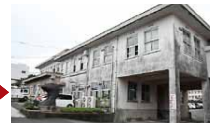
▲老朽化の進む庁舎別館の大規模改修工事及びトイレ改修工事を実施します。
