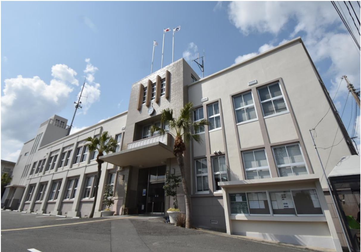
市役所本庁舎耐震補強工事完成写真
