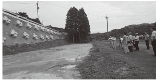
擁壁・法面変状対策事業の調査
