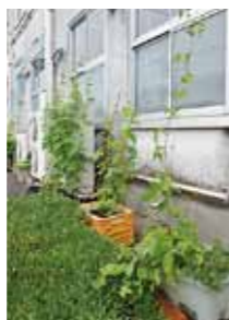
市役所庁舎に設置された緑のカーテン
