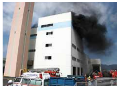
火災が発生した内鍋清掃センター(平成21年)
