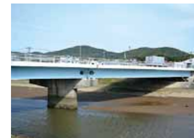
▲橋りょう補修の詳細設計を順次行い、橋りょう補修工事に着手し、橋の安全確保に努めます。
