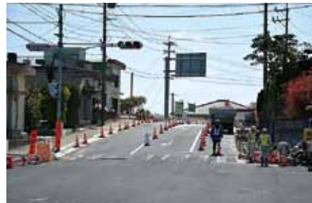
▲坂道でカーブの多い中原工区(写真)は現在改良工事を行っています。
