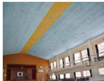
▲小・中学校の屋内運動場等における非構造部材の耐震化を集中的に実施します。
