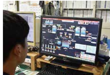
▲水の状況の監視
