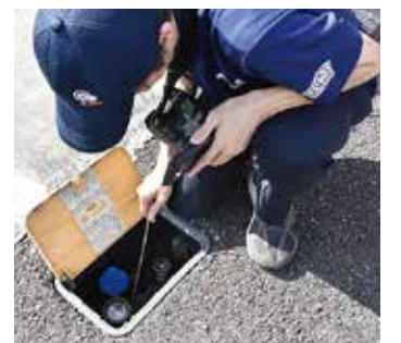
▲水道メーター器の検針
