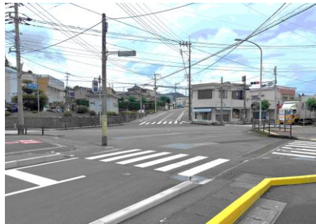
【エネオス前の五差路】 ・大雨時に水はけが悪い。
