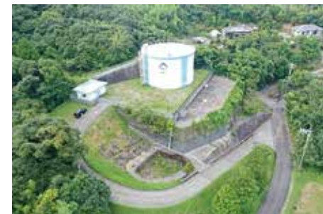
地上にタンクを設置している木場配水池
