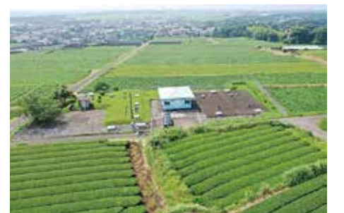
地下にタンクを埋設している俵積田配水池
