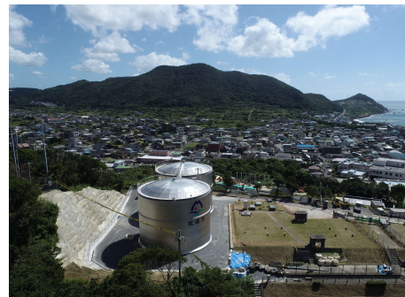
片平山配水池
