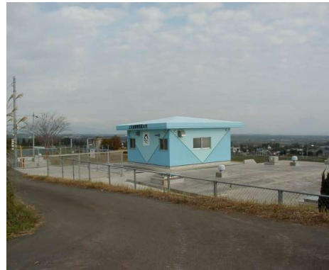
俵積田配水池
