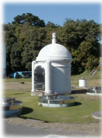
深浦ポンプ場 シンボルの円筒の建物
