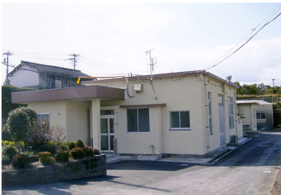
深浦ポンプ場管理棟
