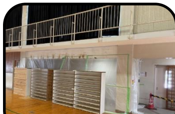
④ 体育館靴箱（バリアフリーストイル）
