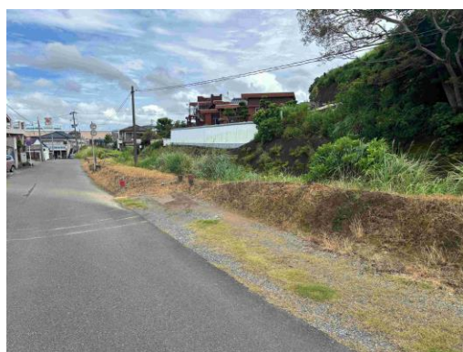
【東本町 JR 線路近く】 ・線路沿いにフェンスがない。
