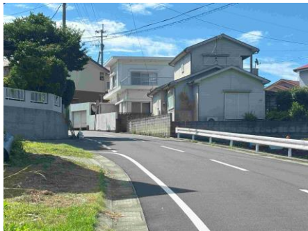
【湯山団地付近から木場に至る道路】
