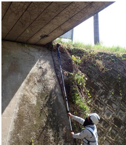
ポールカメラによる点検状況
