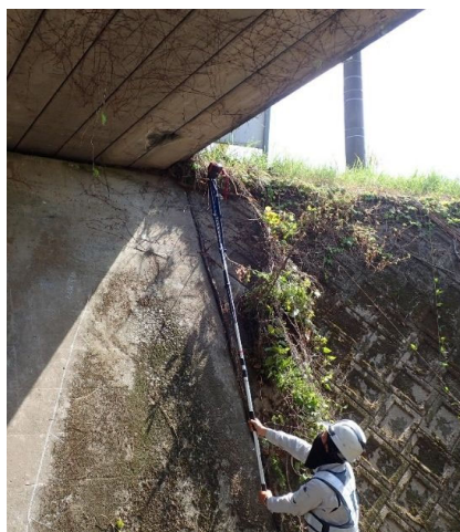
ポールカメラによる点検状況
