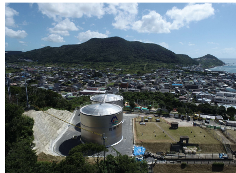
片平山配水池
