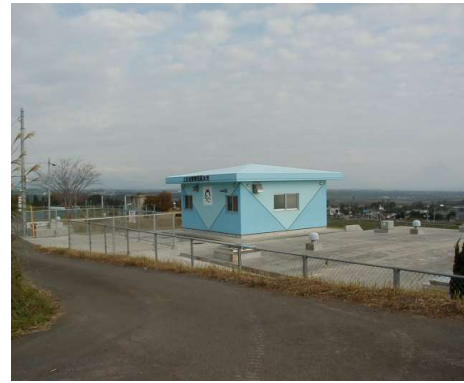
俵積田配水池
