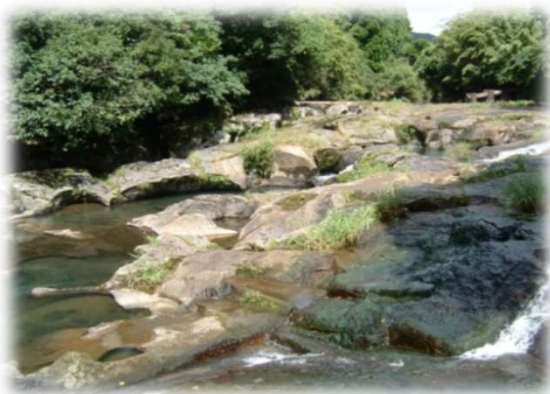
金山浄水場取水口付近
