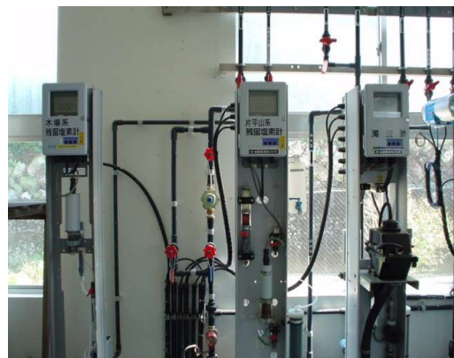
深浦水源地濁度計・残塩計
