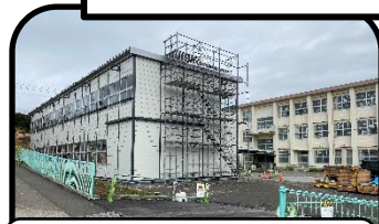
道路側からの様子
