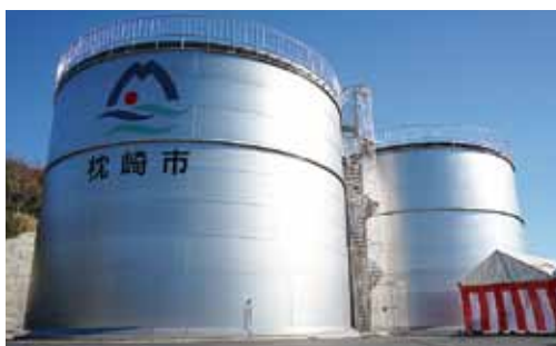
▲更新後の第1、第2配水池本体
