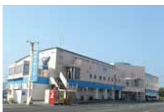
枕崎お魚センター
