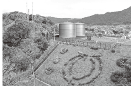
片平山配水池
