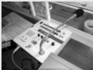
駒水公民館：無線放送施設設置
