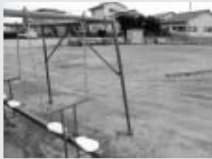
大堀公民館：大堀西公園整備
