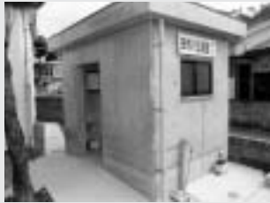
田布川公民館：公衆便所設置
