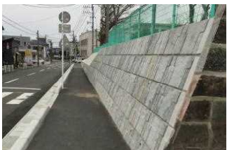
学校周辺の法面
