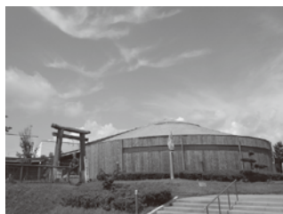
大規模改修工事が計画されている南浜館
