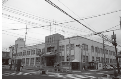
耐震工事が完了した庁舎
