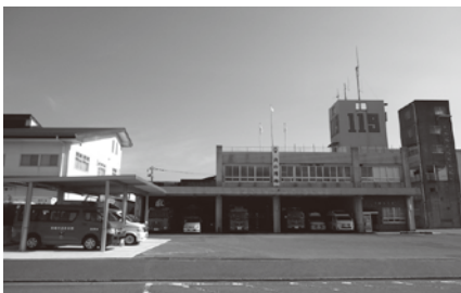
枕崎市消防署
