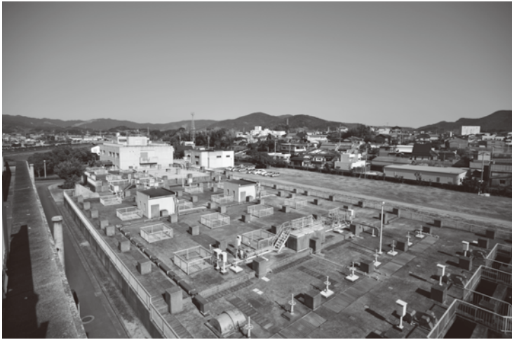
下水道処理施設
