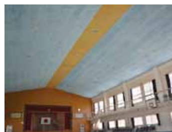
▲学校の体育館を児童生徒が安心して利用できるように、「天井及び照明施設の落下防止改修工事」を集中的に実施します。
